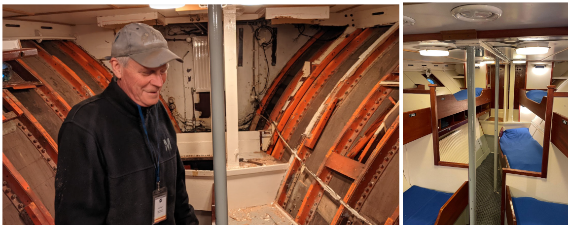
Förliga skansen under och efter renoveringen
