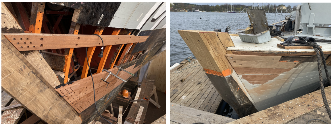
Förskepptr under renovering. Ny stäv, nya bord, reparerade spant och laskbrickor.
