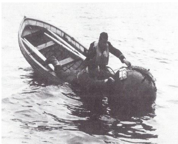
Aptering av trotyllladdning på en mina
